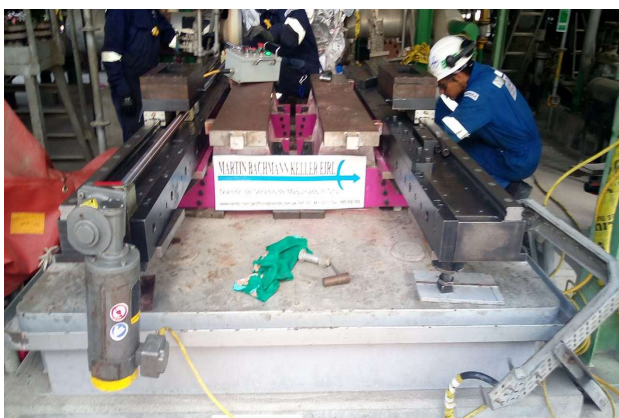
Montaje de los distanciadores del travesaño
