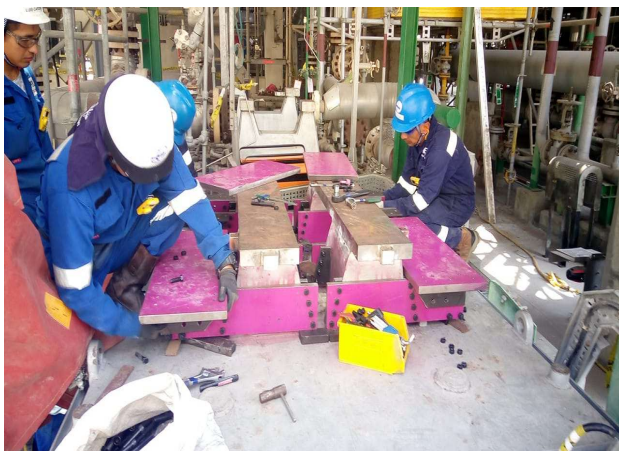
Montaje de las mesas sobre las escuadras (09)
